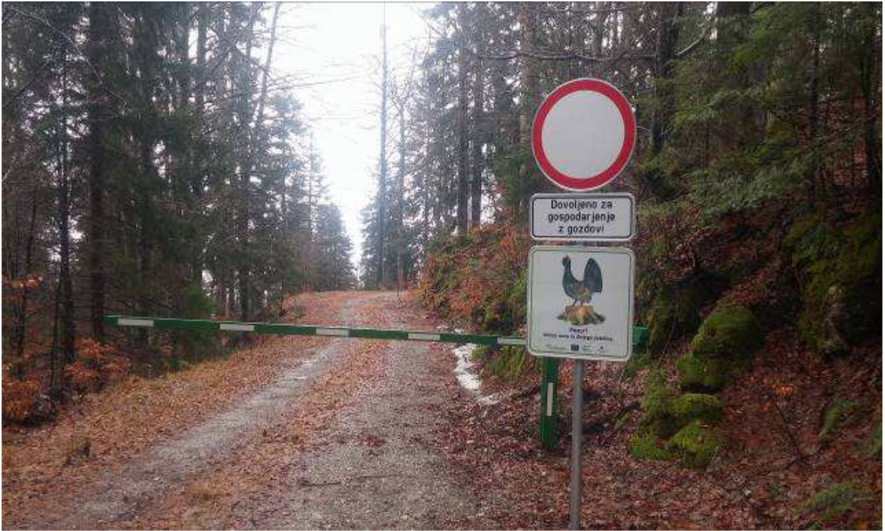
Slika 3: Primer mehanske zapornice slepega kraka gozdne ceste s pripadajočo prometno signalizacijo znotraj mirne cone za divjega petelina. (foto: arhiv ZGS OE Kočevje)
